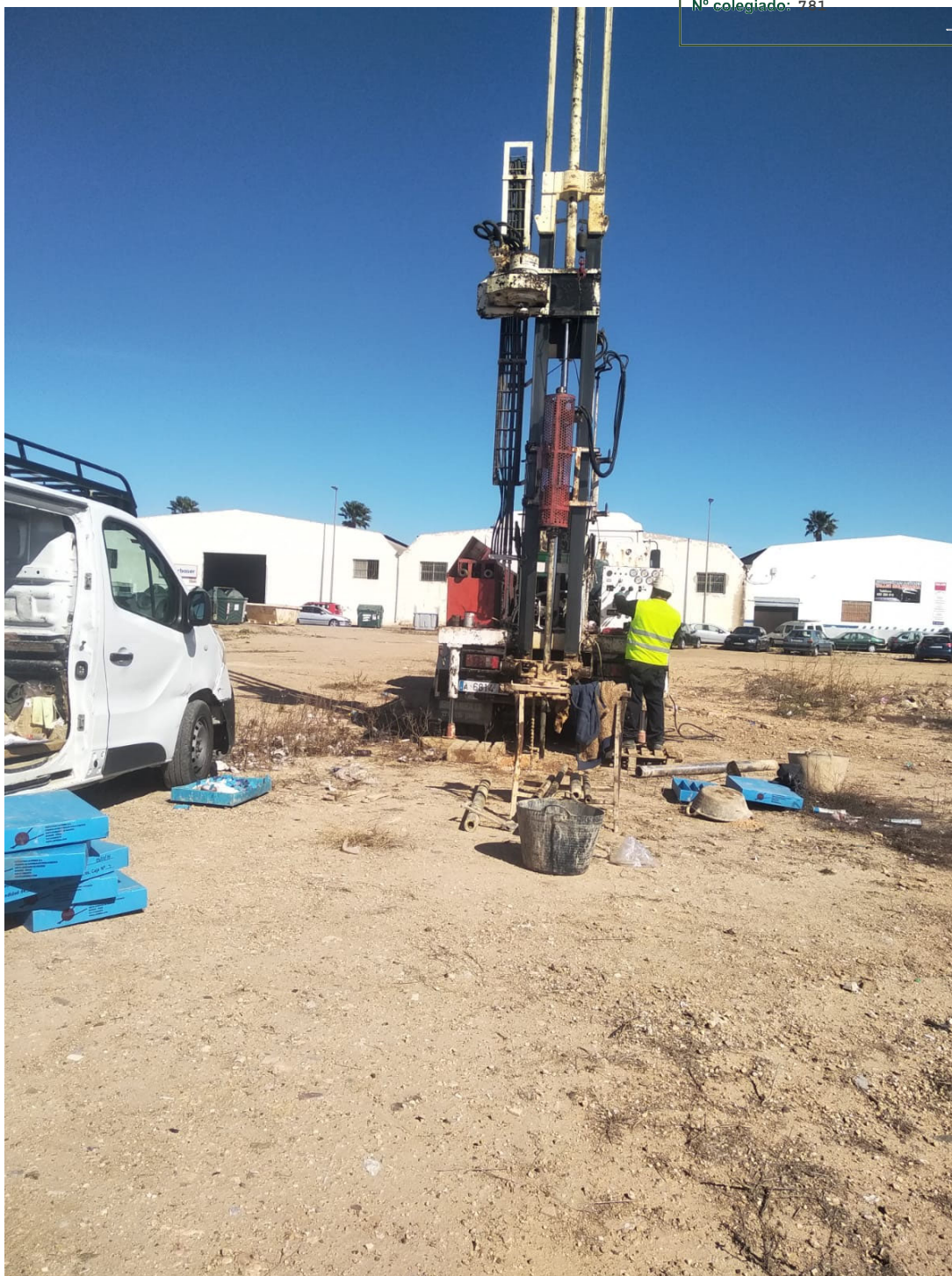
Ejecución del sondeo S-5.
