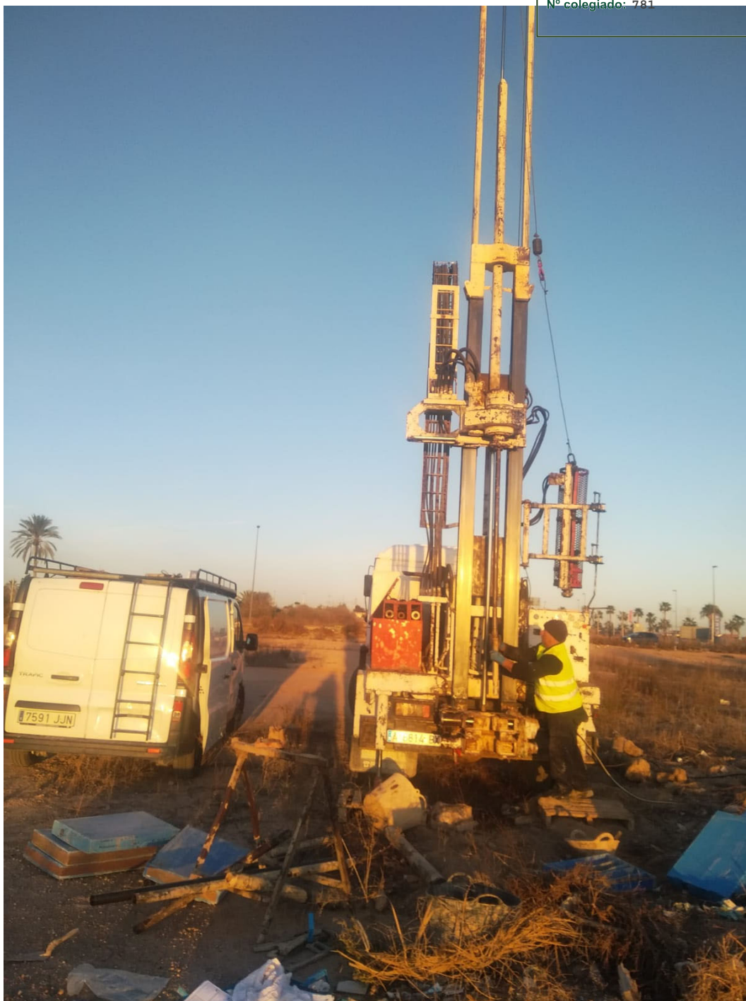
Ejecución del sondeo S-3.
